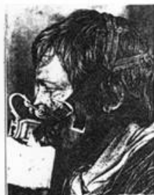
Χρήση συσκευής αυτοδιάσωσης σε Υπόγεια Τεχν. Έργα.
