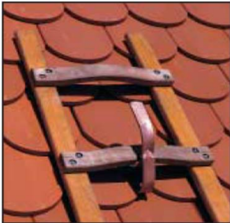
Γάτζος ασφαλείας για την τοποθέτηση σκάλας.
