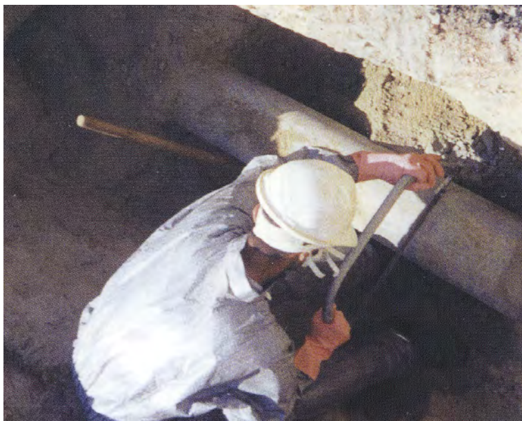
Κοπή αμιαντοσωλήνα, με χειροκίνητο πριόνι
