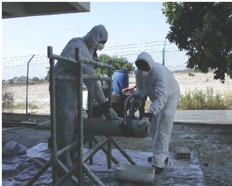
Εργασίες με αμιαντοσωλήνες
