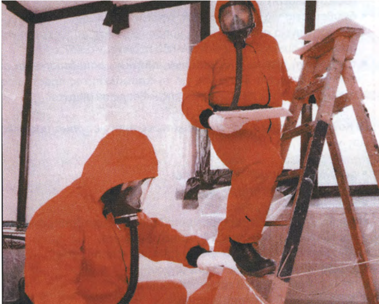
Εργασίες με μόνωση αμιάντου
