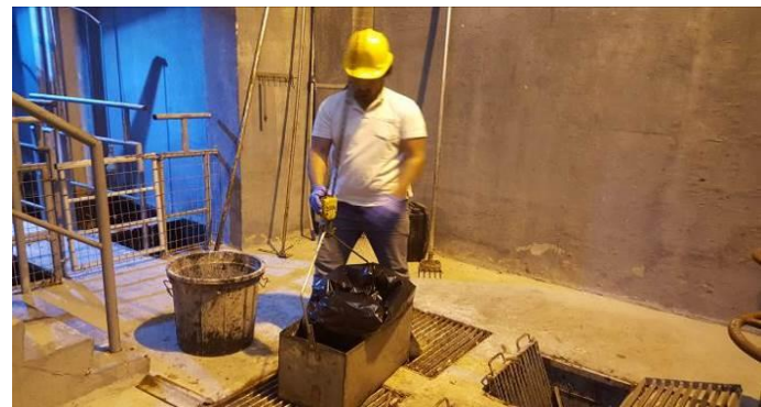
Απομάκρυνση σχαρισμάτων από υπογείο με γερανό.
