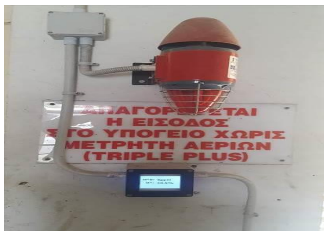
Φωτεινή ένδειξη μέτρησης αερίων και σειρήνα.
