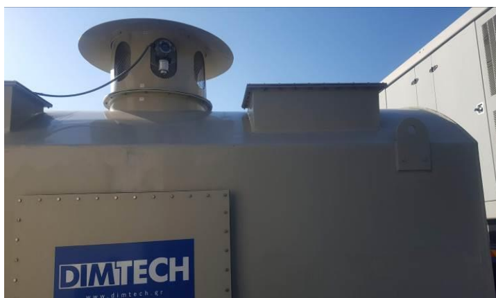
Αισθητήρες μέτρησης αερίων στην έξοδο του φίλτρου απόσμησης
