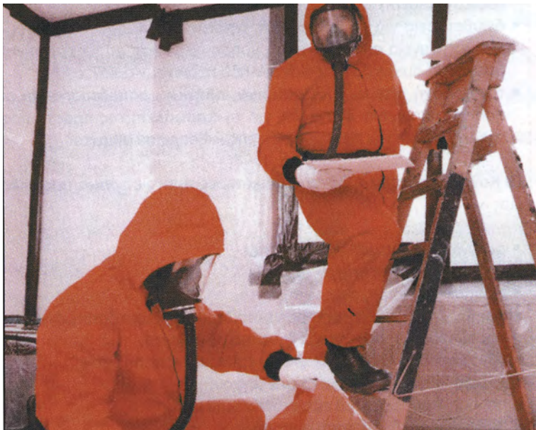
Εργασίες με μόνωση αμιάντου
