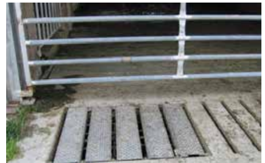
Επανατοποθέτηση καλυμμάτων μετά το πέρας της εργασίας
